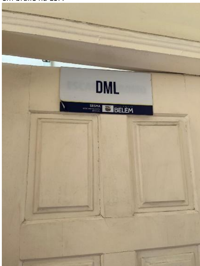
Figura 1. Foto evidenciando a falta de identificação em braile na ESF.
